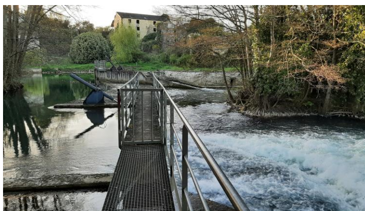
Figure 30 : le barrage de Comporte sur la Sèvre Niortaise, à Niort (79) le 31/03/2025
